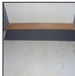
Rampe klar til brug
